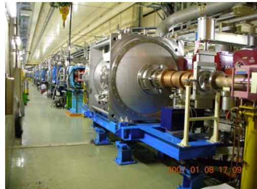
图 4 KEKB 加速器隧道
