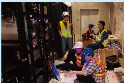
大亚湾实验的科研人员在地下实验室里工作
